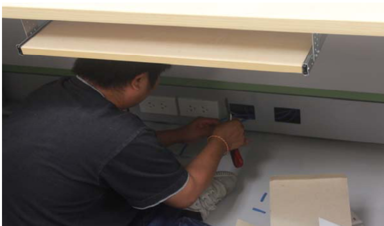
รูปที่ 3.10 ติดตั้ง Outlet
