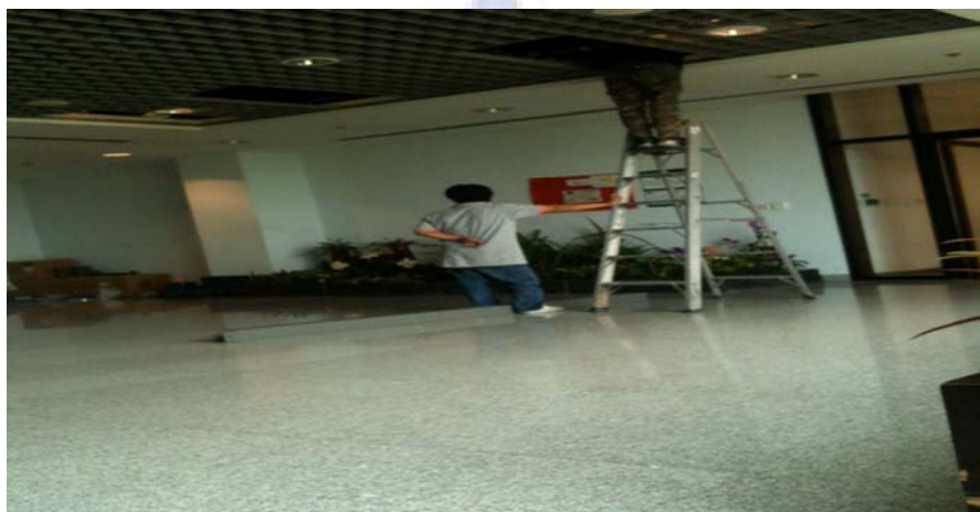
รูปที่ 3.2 ตรวจสอบพื้นที่ในการติดตั้งสาย
