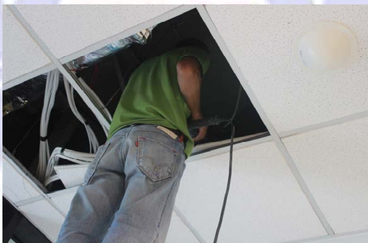
รูปที่ 3.3 ทำการติดตั้ง Wireway
