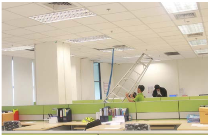
รูปที่ 3.8 นำสายมาประจำจุด Outlet
