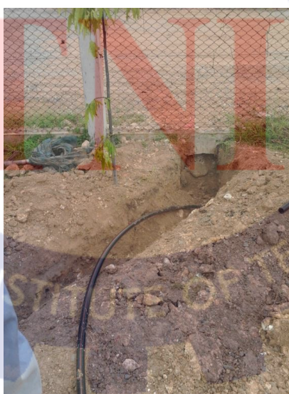
รูปที่ จ.2 ใส่ปลอกหนาเพื่อกันสาย Cable แตก
