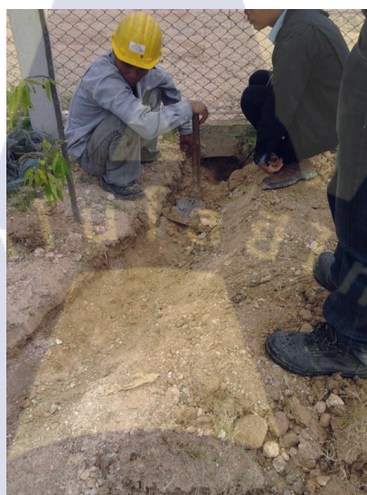
รูปที่ จ.1 เริ่มเดินสาย Cable เข้าตึกใหม่
