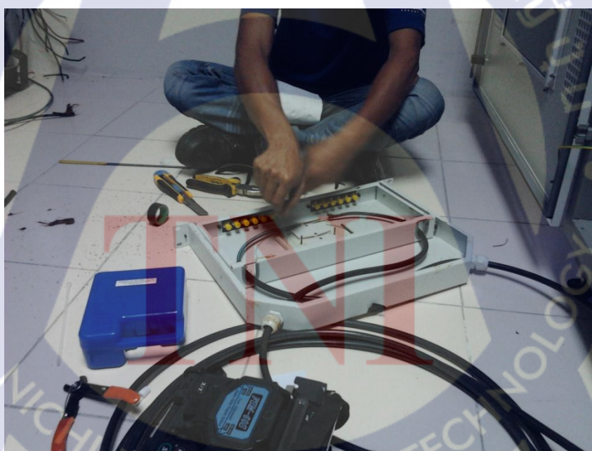
รูปที่ จ.4 นำสายเคเบิลใส่กล่องเพื่อใช้ในการเชื่อมต่อ
