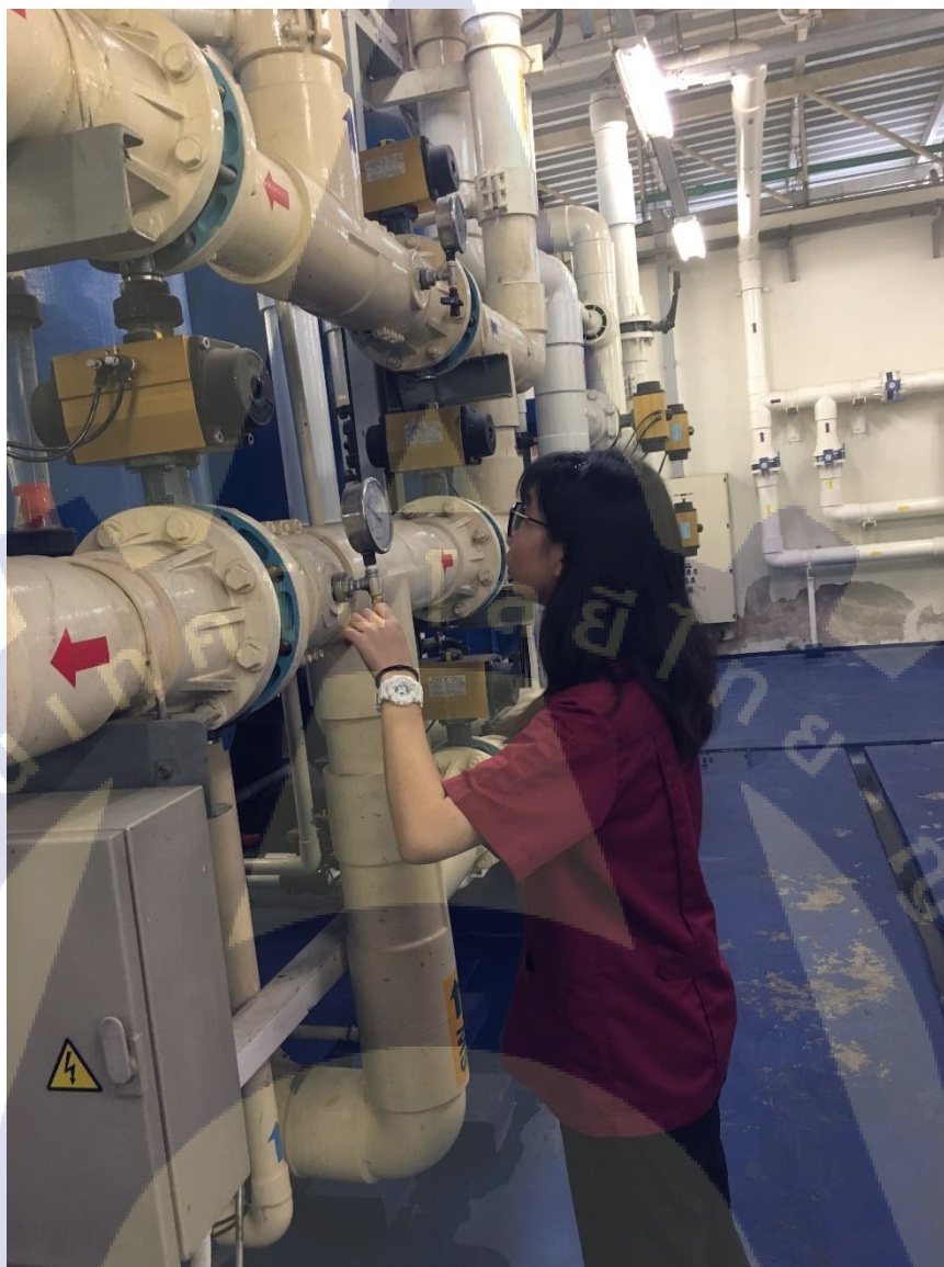
ภาพที่ 3.3 สํารวจสถานที่จริงเพื่อทำความเข้าใจแบบแปลน ห้อง RO Water
