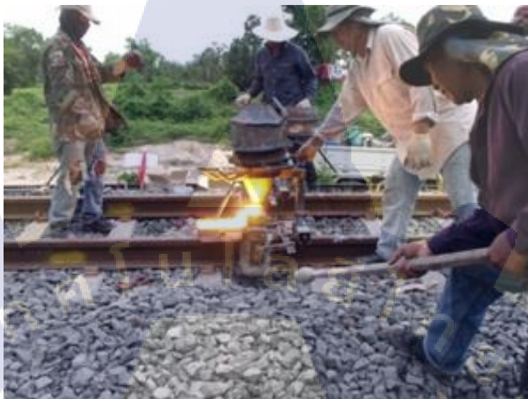
ภาพที่ 2.17 ภาพการเชื่อมรางรถไฟ [19]
