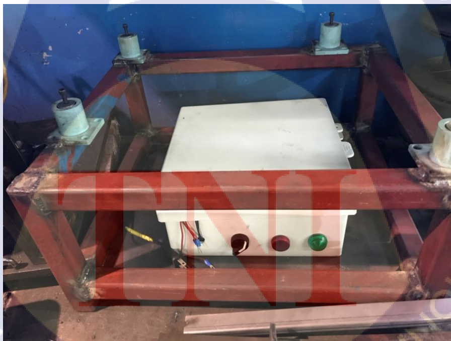
รูปที่ 3.16 ทดลองวางกล่องควบคุมบนฐานเหล็ก
