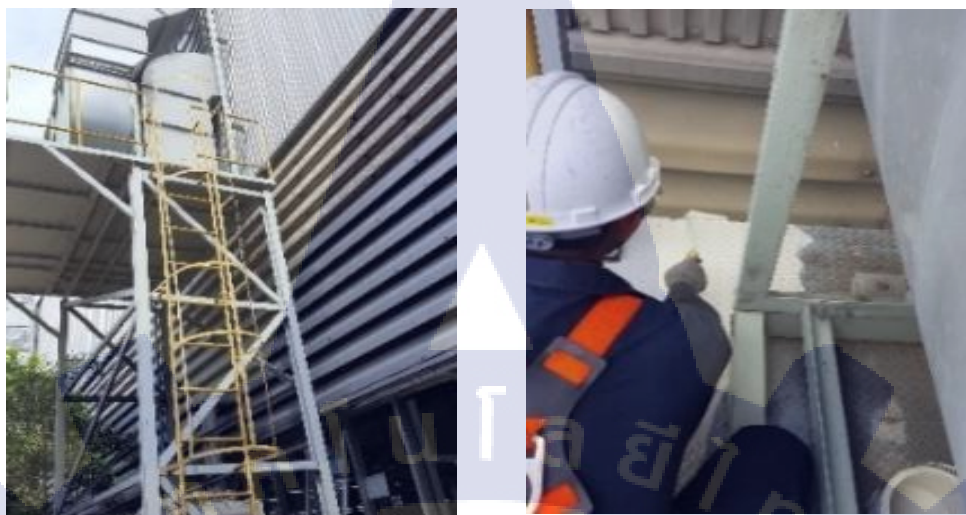
ภาพแสดง การเปลี่ยนสายพานของBlower
