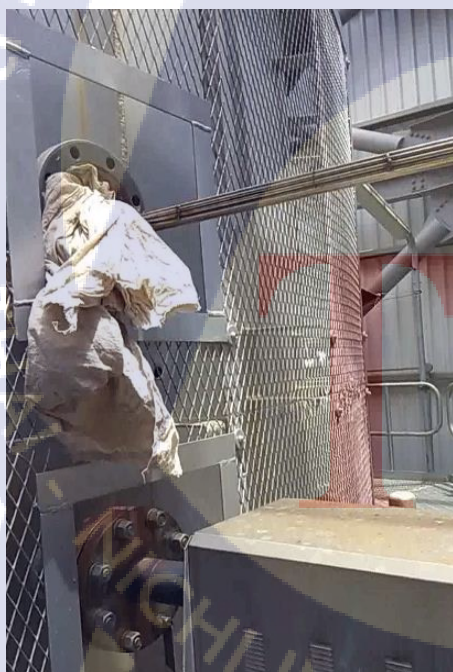
ภาพที่ 3. 15 แสดงตำแหน่งของจุดเก็บ ตัวอย่างตามขนาดของปล่องจุดที่ 3
