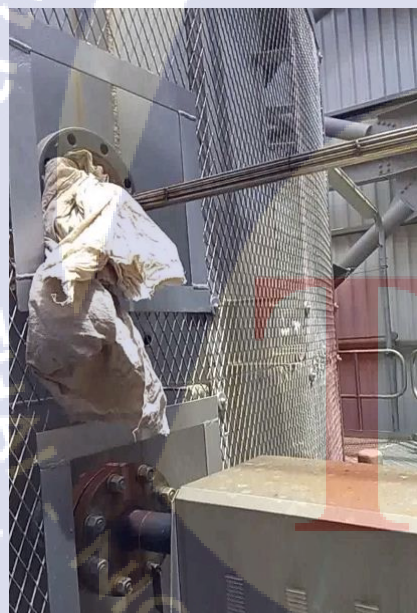
ภาพที่ 3. 28 แสดงตำแหน่งของจุดเก็บตัวอย่างตาม ขนาดของปล่องจุดที่ 3
