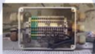
ภาพที่ 27 ต่อสายไฟของฮีตเตอร์
