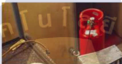
ภาพที่ 14 สายกลางของเกจให้ต่อกับถังเติมน้ำยา
