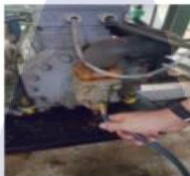
ภาพที่ 5 ต่อต่อเกจด้านLowกับSuction valve
