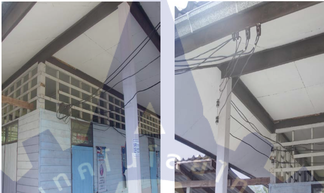
ภาพที่ ๓.5 งานปรับปรุงสายเมนและสายโทรศัพท์ 3.
