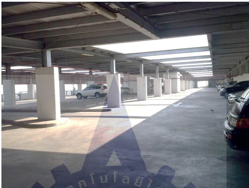
ภาพที่ 3.5 ภายในอาคารจอดรถยนต์ P - 1 ชั้น 8
