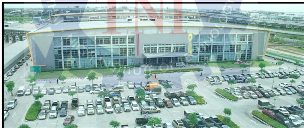
ภาพที่ 1.10 อาคารสำนักงานกรมศุลกากร ท่าอากาศยานสุวรรณภูมิ
