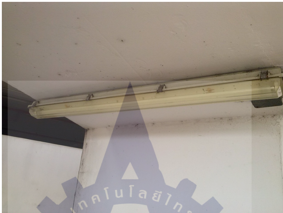
ภาพที่ 3.7 หลอดไฟ Fluorescent ภายในอาคารจอดรถยนต์ P - 1
