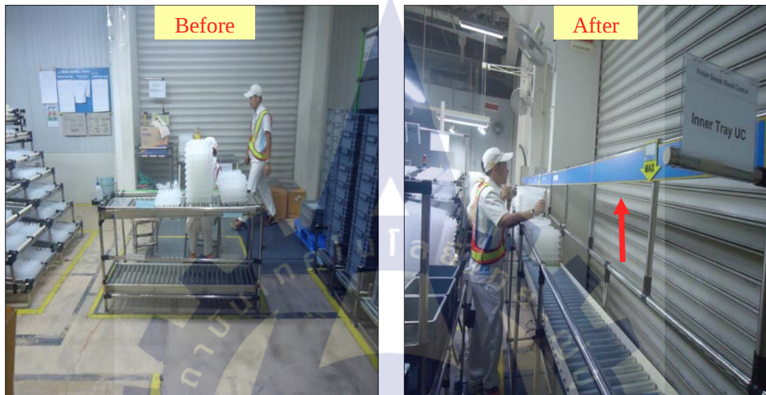
รูปที่ 4.6 รูปแสดงการติดตั้งคานา
