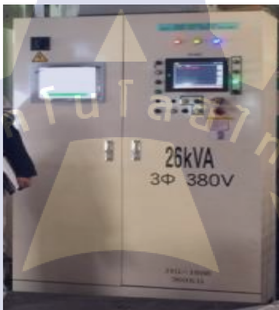
รูปที่ 4.19 การล็อกตู้ควบคุมเพื่อป้องกันไม่ให้ผู้ที่ไม่เกี่ยวข้องมาทำการแก้ไข ที่มา : บริษัท ฮีโน่ มอเตอร์ส แมนูแฟคเจอร์ริง (ประเทศไทย) จำกัด
