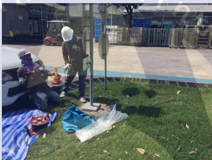
กลุ่มผู้รับเหมาติดตั้งป้ายจราจร
