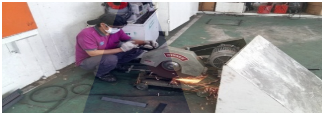
ภาพที่ 4.2 ขั้นตอนตัดเหล็กเส้นขึ้นโครง
