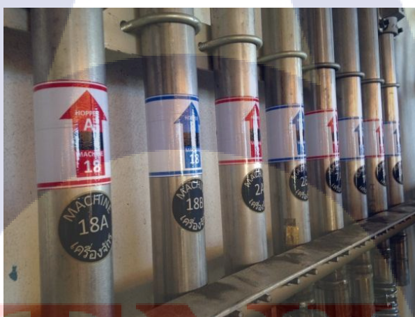
รูปภาพที่ 4.9 การกำหนดสีและคุณลักษณะของท่อน้ำเลี้ยง (ท่อน้ำดึง)
