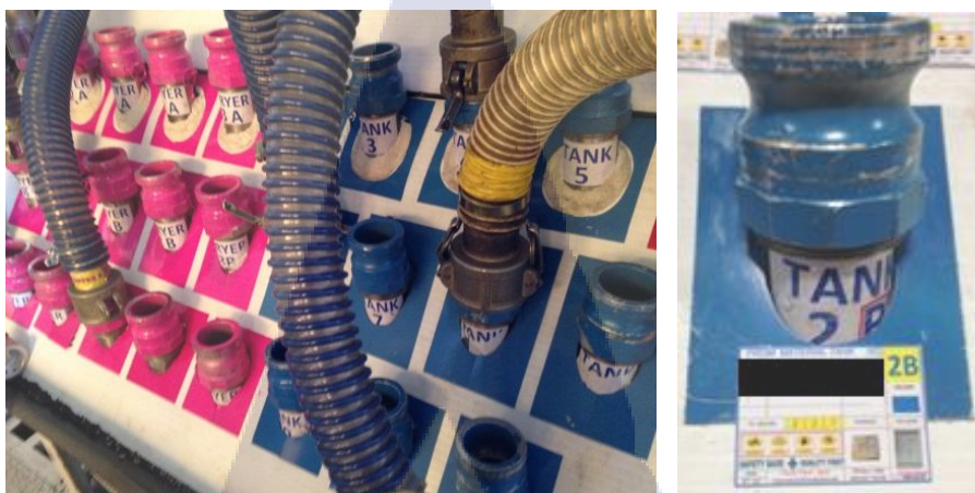
รูปภาพที่ 4.8 การกำหนดสีและคุณลักษณะของท่อน้ำเลี้ยง (ท่อน้ำส่ง)
