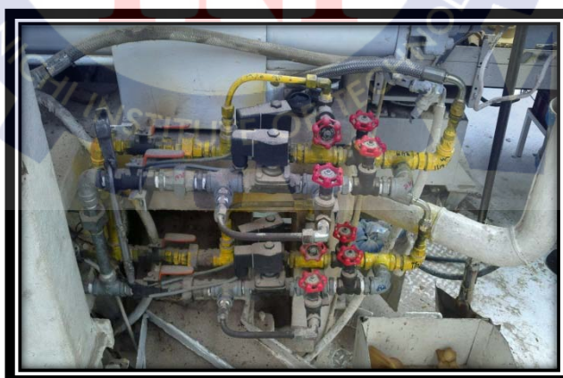
ภาพที่ 3.17 ชุดการอุ่นแม่พิมพ์ทรายหลังการติดตั้ง
