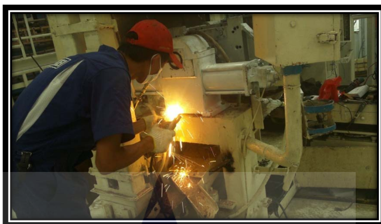
ภาพที่ 3.15 การทำฐานยึดชุดการอุ่นแม่พิมพ์ทราย
