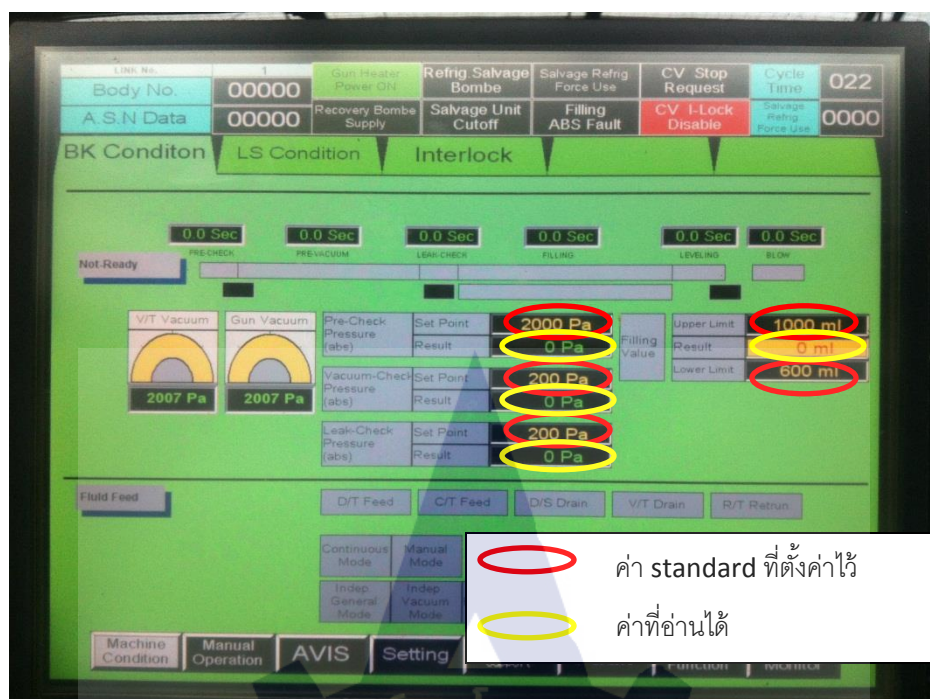
รูปที่ 2.39 Monitor แสดงค่า Pre-vacuum check, Vacuum check, Leak – check และ Filling โดยแสดงค่า standard ไว้ด้วย
