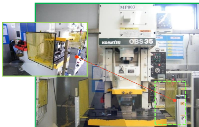
ภาพที่ 4.2 เครื่อง Single หลังการติดตั้ง Safety Guard
