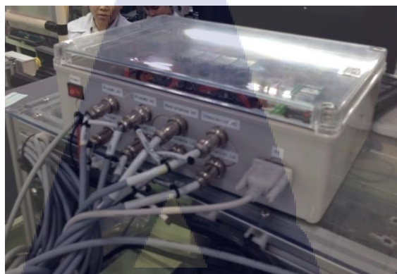
รูปที่ 3.14 การติดตั้งสายเข้ากับ I/O digital
