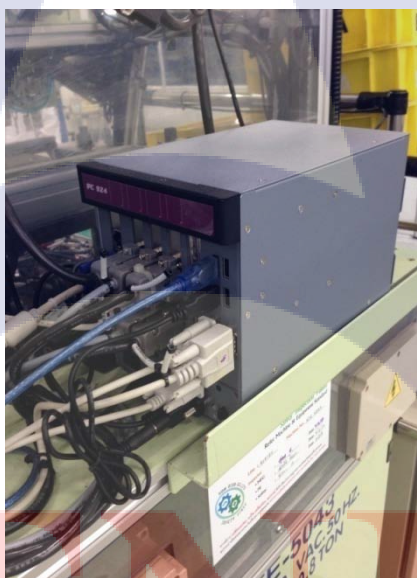
รูปที่ 3.13 การติดตั้งสายเข้ากับ Industrial PC
