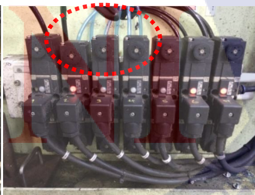
รูปที่ 3.23 การติดตั้ง อุปกรณ์ลม
