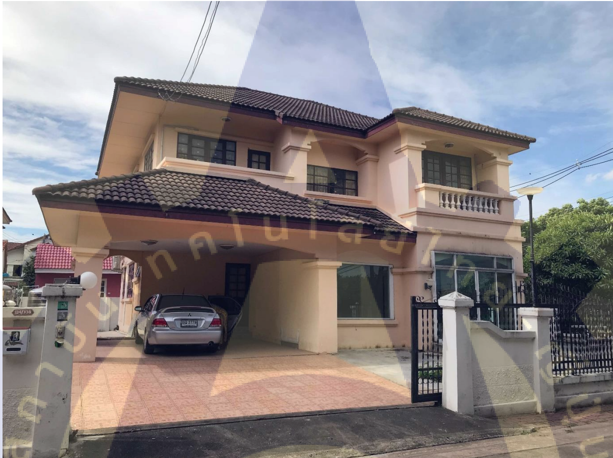
ภาพ ก.2 ดูหน้างาน อาคาร เพื่อทำการ Renovate
