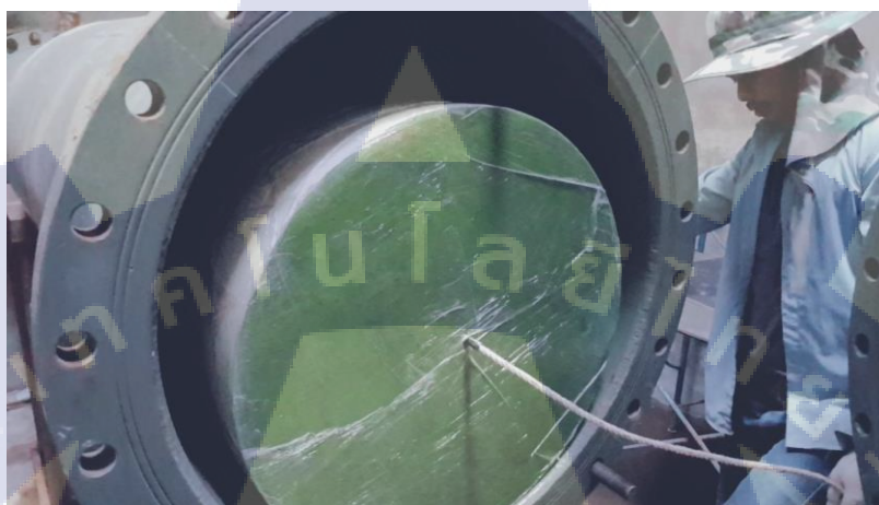
ภาพที่ 1.14 การติดตั้งปลายเชือกกับ Pig
