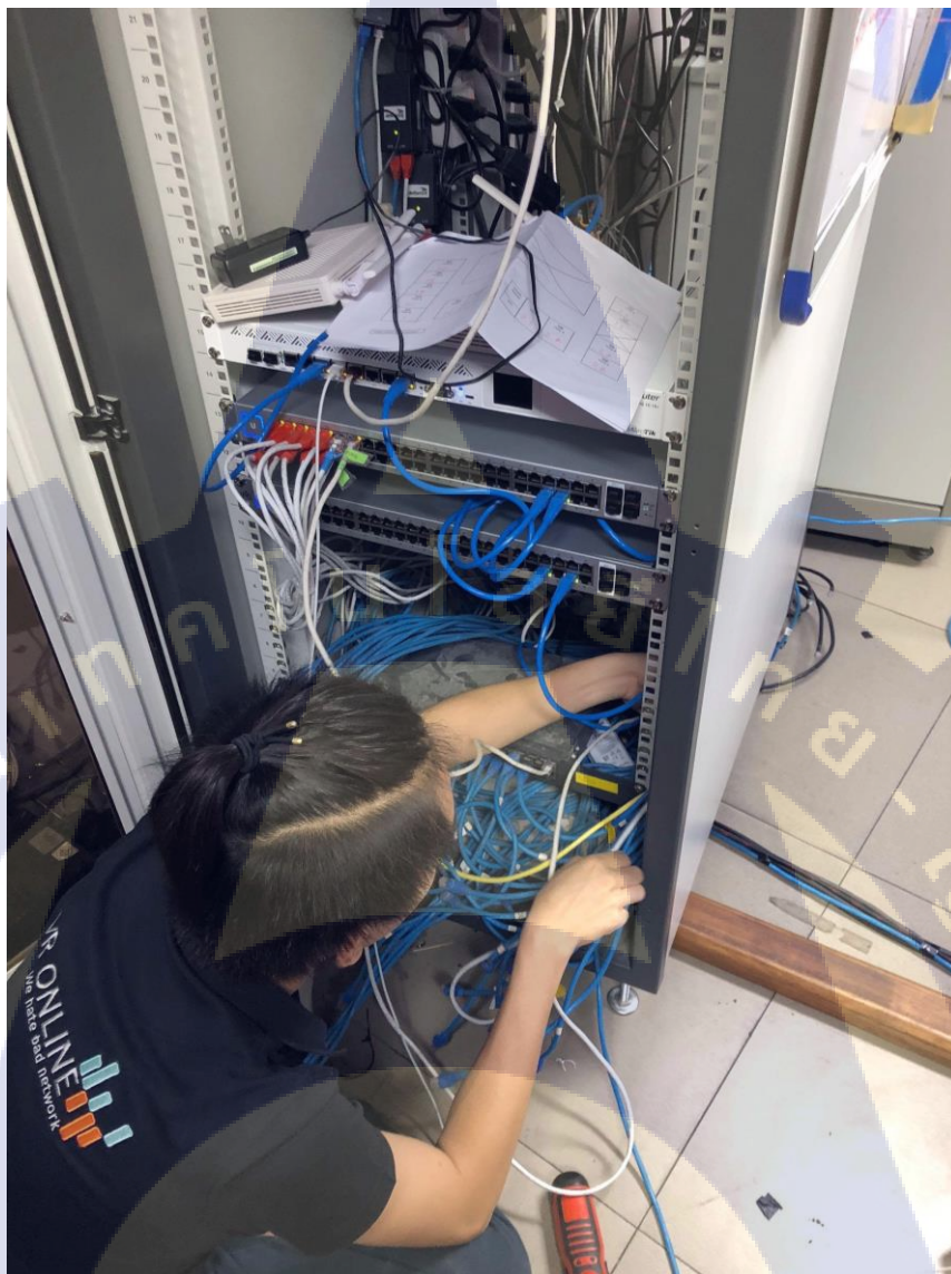
รูปที่ 3.23 ติดตั้งอุปกรณ์และย้ายสู่ระบบใหม่
