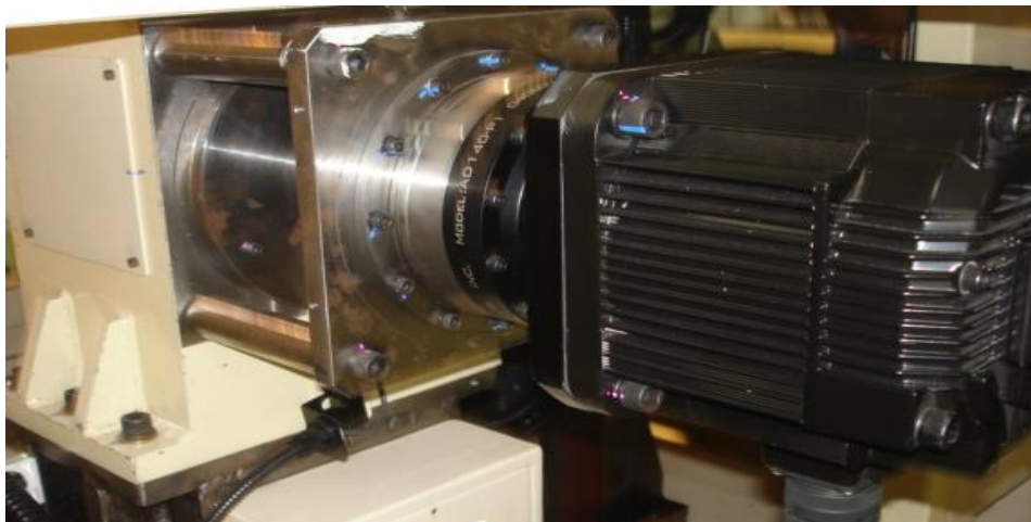
รูปที่ 21 การติดตั้งเซอร์โวมอเตอร์
