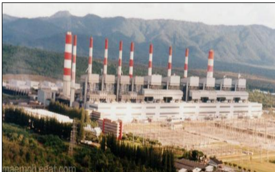
รูปที่ 2 โรงไฟฟ้าแม่เมาะ
