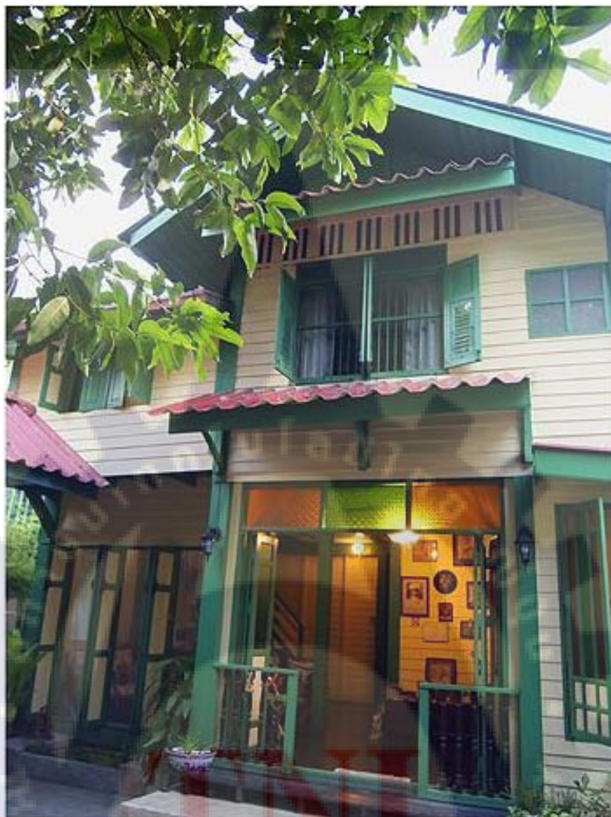
รูปที่ 21 ตัวอย่างอาคารโรงแรม
