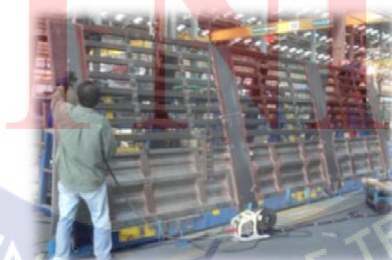
รูปที่ 26 ติดตั้งรั้วโปร่งและแผงข้าง
