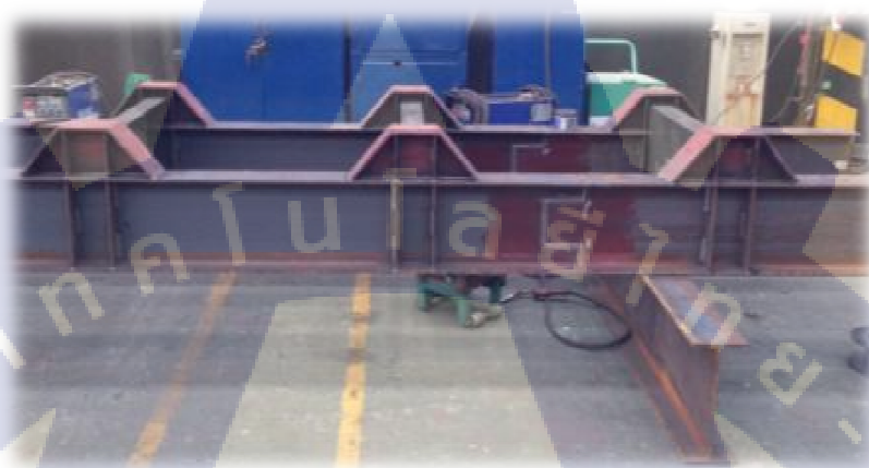
รูปที่ 17 ติดตั้งชุด T-Beam เข้ากับเมนเฟรม
