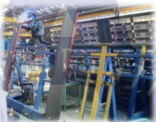
รูปที่ 25 ติดตั้งคานด้านบนซ้ายและขวา
