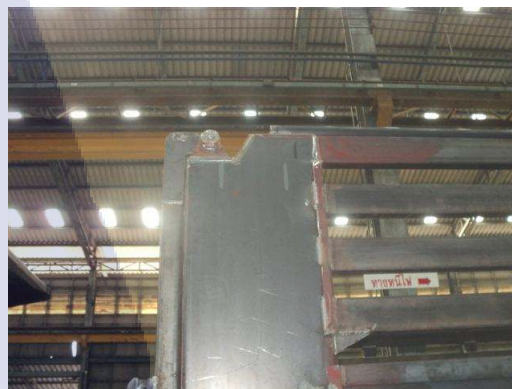
รูปที่ 51 การบากหัวเสา หลังปรับปรุง
