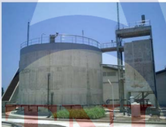
รูปที่ 3 ลักษณะของระบบผลิตก๊าซชีวภาพแบบ Upflow Anaerobic Sludge
