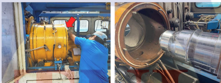
รูปที่ 11 การถอดแยกอุโมงค์ออกจากหัวแบบบานท้อ
