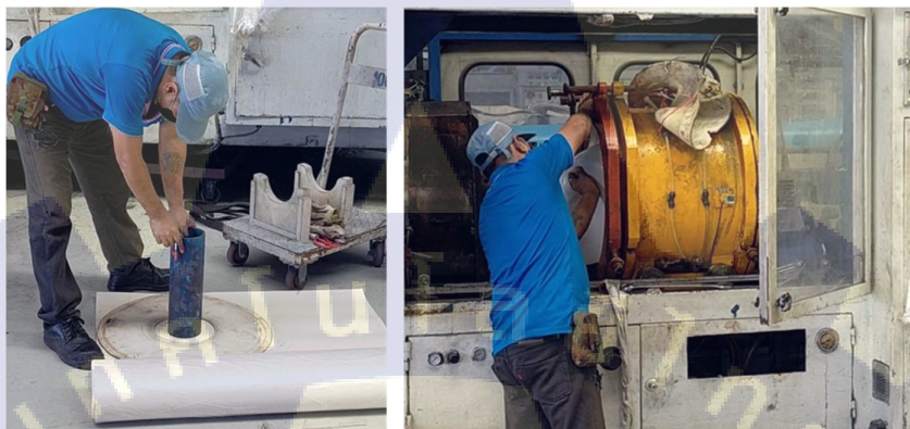
รูปที่ 16 การเปลี่ยนแผ่นยางกันลมและกันน้ำ
