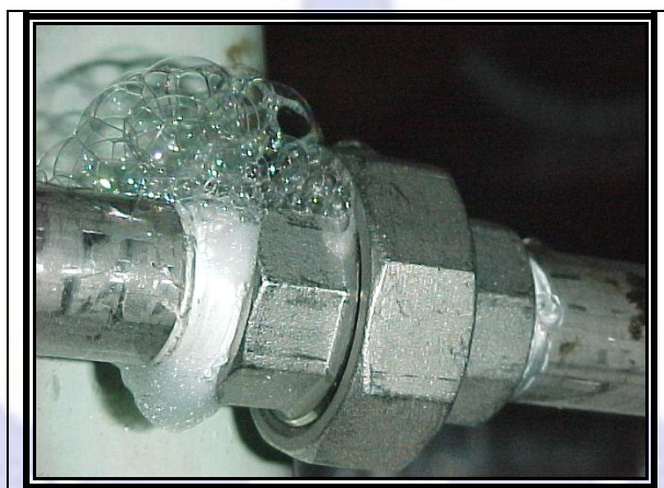
รูปที่ 6 ตัวอย่างการทดสอบการรั่วไหลของท่อลมสำหรับระบบอากาศอัด
