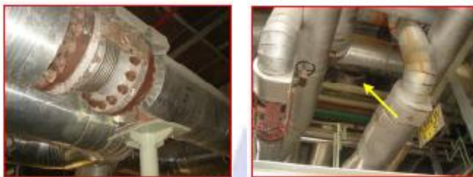
รูปที่ 13 การหุ้มฉนวนท่อไอน้ำ
