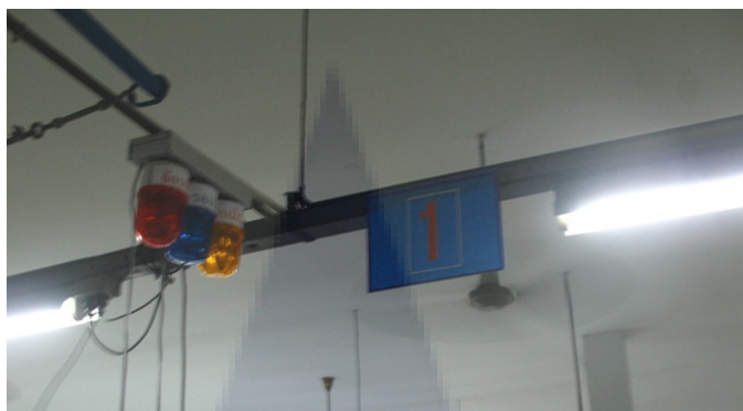
รูปที่ 23 แสดงการติดตั้งไฟแจ้งเตือนในพื้นที่แผนกตัดผ้าโต๊ะที่ 1
