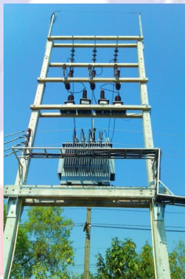
รูปที่ 9 มิเตอร์แบบ 3 เฟส 3 สาย ประกอบซีทีฟීที ขณะติดตั้งใช้งาน
