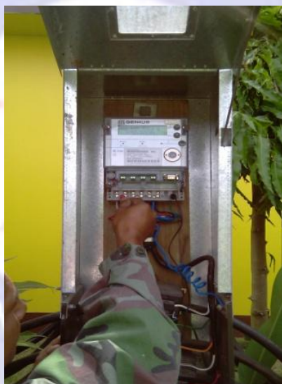
รูปที่ 27 วัดค่าต่างๆ ของมิเตอร์โดยเครื่องวัดคลิปปอนน์กิโลวัตต์
