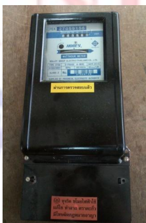
รูปที่ 4 มิเตอร์แบบ 3 เฟส 4 สาย แบบจานหมุน
