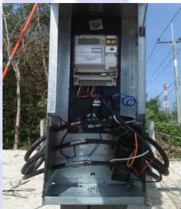
รูปที่ 6 มิเตอร์แบบ 3 เฟส 4 สาย ประกอบซีที ขณะติดตั้งใช้งาน
