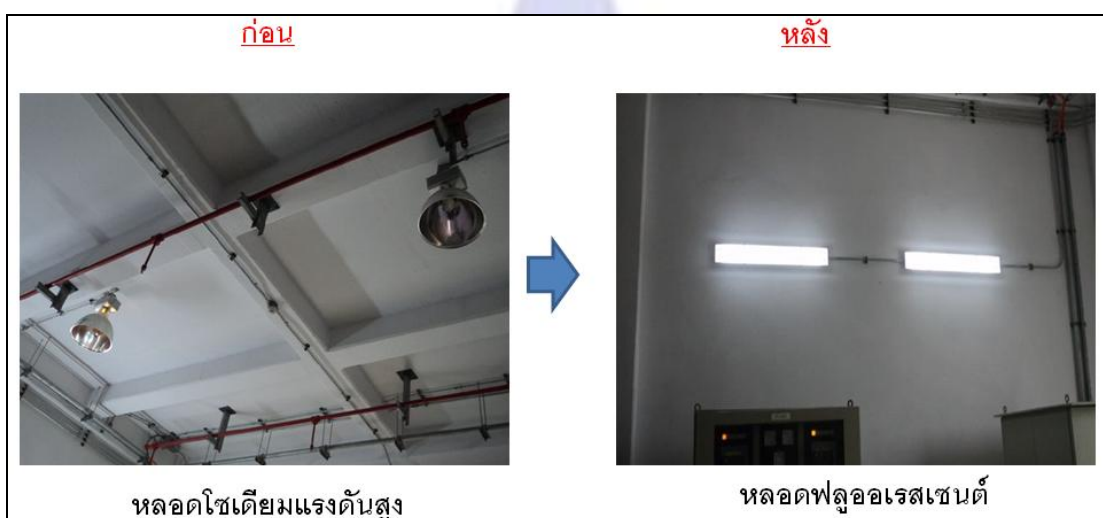
รูปที่ 17 มาตรการการนำหลอดฟลูออเรสเซนต์ทดแทนหลอดโซเดียมแรงดันสูง
