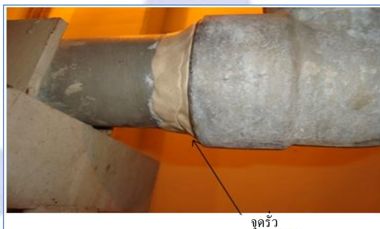
รูปที่ 19 ตำแหน่งจุดรั่วของท่อลมกระบวนการผลิตและการแก้ไข
