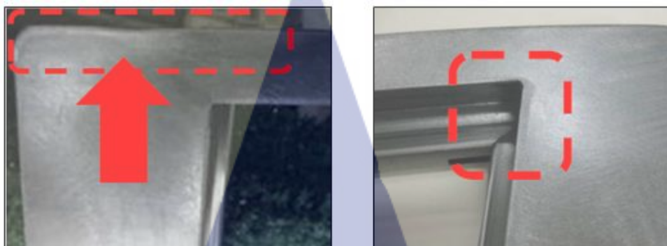
ขัดแต่งมากเกินไป (Over Grinding)
