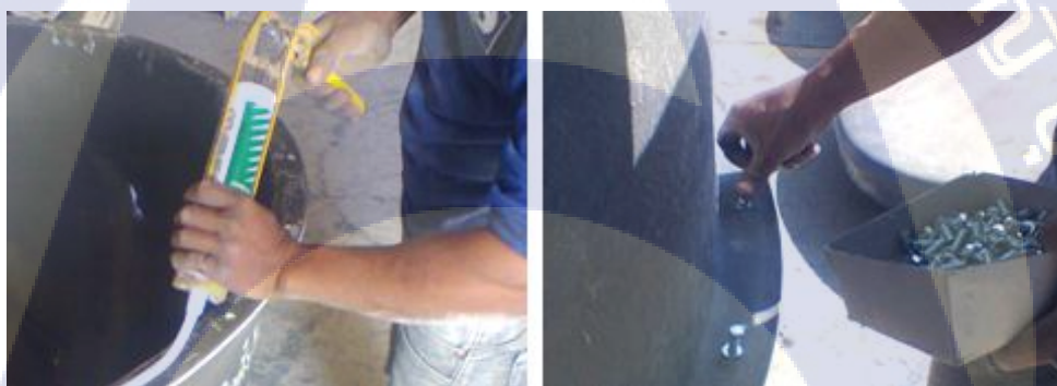
รูปที่ 31 การประกอบตัวถังส่วนบนกับตัวถังส่วนล่าง
