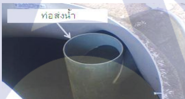
รูปที่ 33 การประกอบท่อน้ำเข้า-ออก
