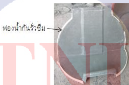
รูปที่ 29 การติดตั้งน้ำที่ขอบผนังกัน
