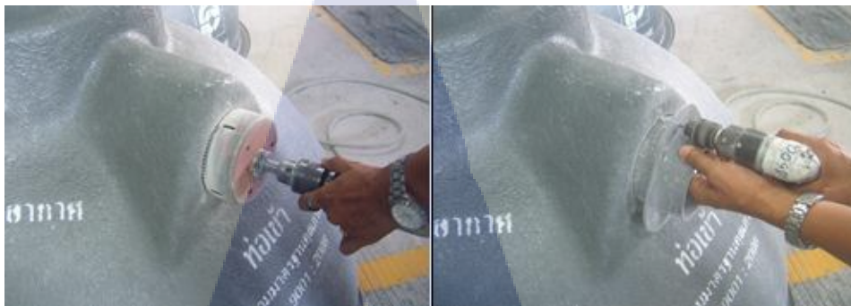
รูปที่ 24 การเจาะรูท่อ
