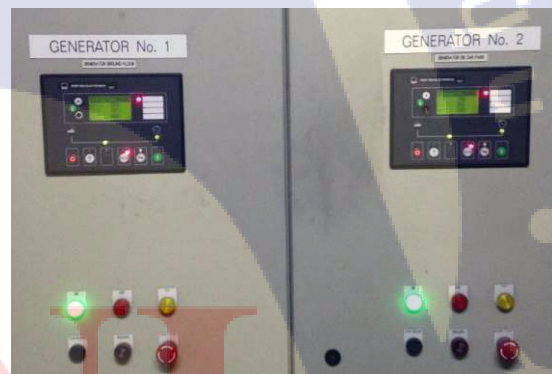
รูปที่ 15 ชุดควบคุมการทำงานของเครื่องกำเนิดไฟฟ้า
