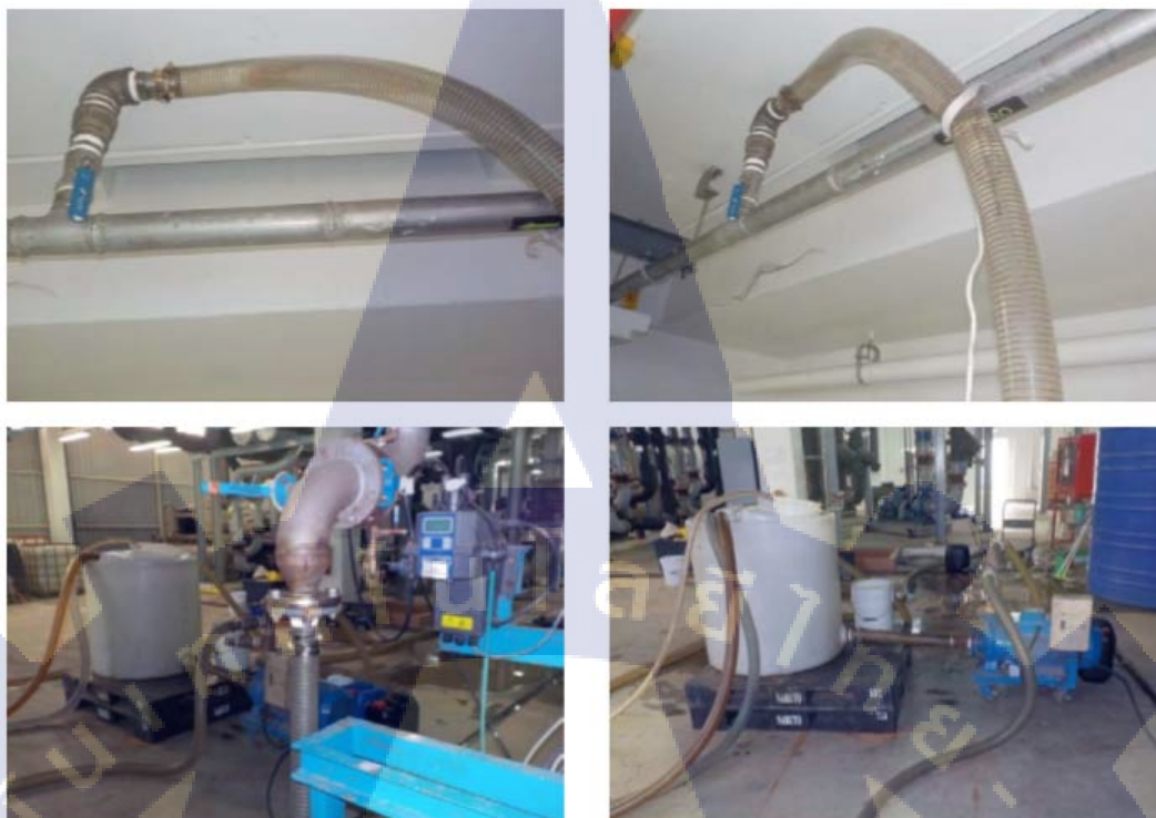
รูปที่ 45 การทำความสะอาดระบบท่อจ่ายน้ำหลักสำหรับใช้ในกระบวนการผลิต
