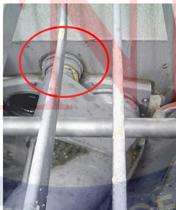
รูปที่ 42 การอัดจารบี Flange Bearing หลังการใช้งาน
