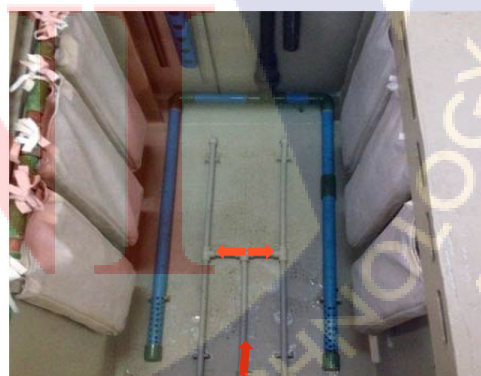
หลังการปรับปรุงท่อลม
