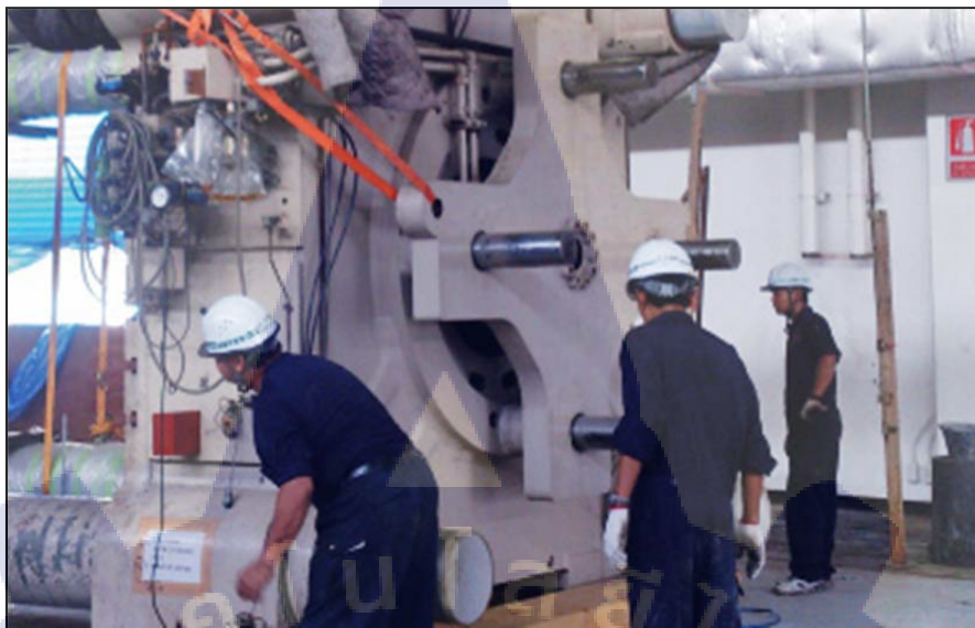
รูปที่ 9 การติดตั้งเครื่องจักร
