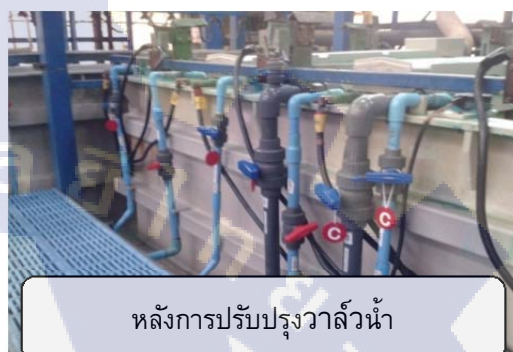
รูปที่ 36 ภาพก่อนและหลังการปรับปรุงวาล์วน้ำร้อน น้ำเย็น
