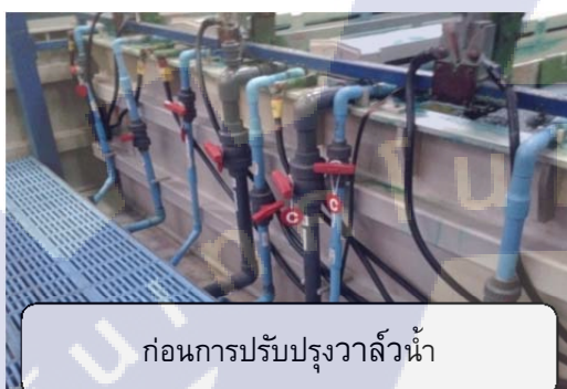
รูปที่ 36 ภาพก่อนและหลังการปรับปรุงวาล์วน้ำร้อน น้ำเย็น
