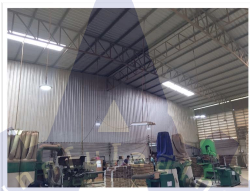
รูปที่ 50 พื้นที่ทำงาน Machine Wood Working ขนาด 200 ตร.ม. หลังเปลี่ยนหลอดไฟ
