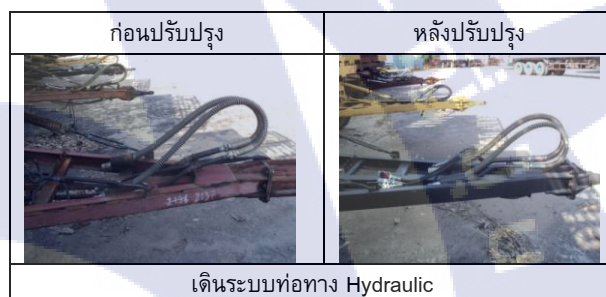
รูปที่ 11 การเดินระบบท่อทาง Hydraulic ก่อนและหลังปรับปรุง
