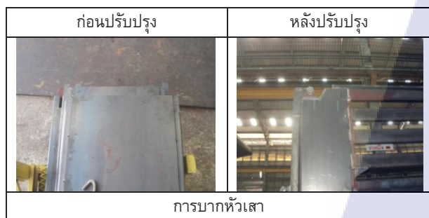
รูปที่ 7 การบากหัวเสา ก่อนและหลังปรับปรุง
