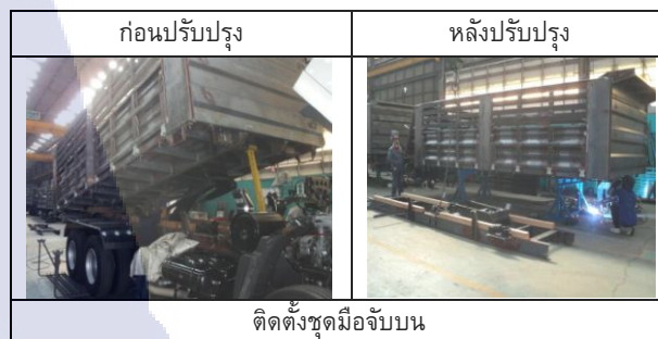
รูปที่ 10 การติดตั้งชุดมือจับบน ก่อนและหลังปรับปรุง
