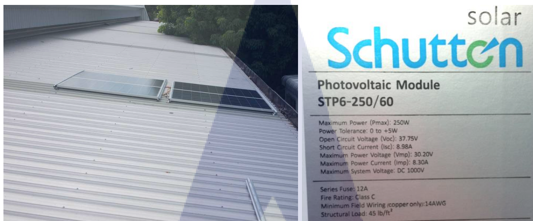
รูปที่ 4.11 โมดูลโฟโตโวลตาอิกยี่ห้อ Schutten ขนาด 250 Watt จำนวน 4 แผง รวม 1000 Watt แรงดันไฟสูงสุด 37.75 Volt DC
