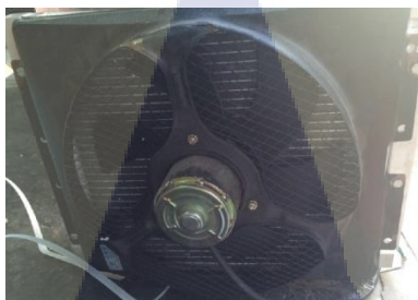
รูปที่ 4.6 พัดลมสำหรับระบายความร้อนจากคอยล์ร้อน ขนาด 12" แรงดันไฟฟ้า 24 Volt 90 Watt
