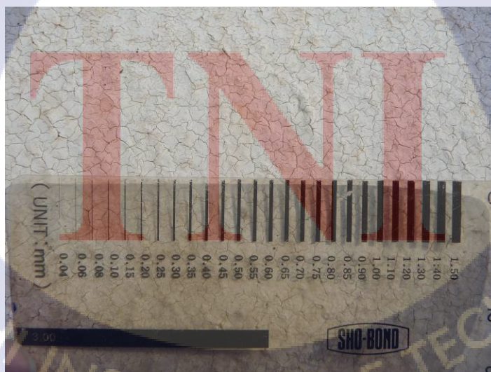
รูปที่ 4.5 ลักษณะรอยร้าวกระจายโดยทั่ว และมีขนาดเล็ก
