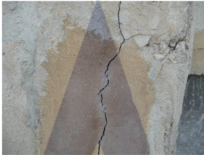
รูปที่ 4.3 ลักษณะรอยร้าวตรง มีผลกระทบของสีของพื้นผิว
