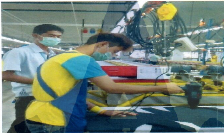
รูปที่ 15 การติดตั้งเครื่องบาลานเซอร์
