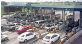
รูปที่ 3 ตู้เก็บเงินค่าทางด่วนที่มีพื้นที่ด้านบนหลังคาที่สามารถติดตั้งชุดแผงโซลาร์เซลล์ได้
