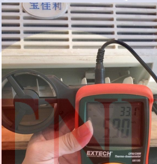
รูปที่ 3.24 การวัดความเร็วลมบริเวณหน้าตัดช่องลมจ่าย
