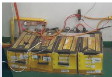
รูปที่ 3.13 แบตเตอรี่ Globatt แบบ Deep Cycle ขนาด 12 Volt 150 Ah 4 ลูก ต่อวงจรเป็นอนุกรมและขนานได้ 24 Volt สามารถสำรองไฟฟ้าได้ประมาณ 6 ชั่วโมง
