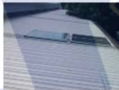
รูปที่ 9 โมดูลแผงเซลล์แสงอาทิตย์ยี่ห้อ Schuberger ขนาด 250 Watt
