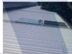
รูปที่ 9 โมดูลแผงเซลล์แสงอาทิตย์ยี่ห้อ Schuften ขนาด 250 Watt จำนวน 4 แผง รวม 1000 Watt
