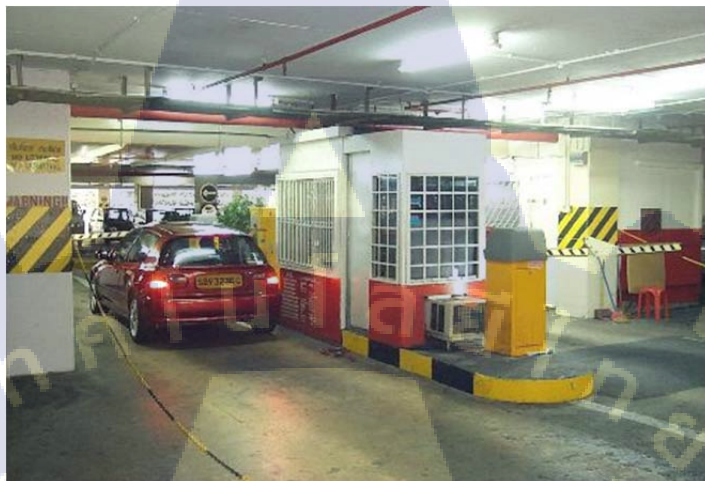
รูปที่ 2.1 การใช้เทคโนโลยีอ่านป้ายทะเบียนกับที่จอดรถยนต์
