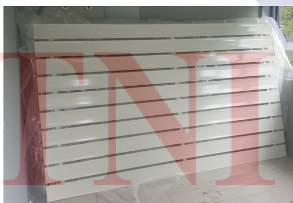
รูปที่ 2.3 ภาพถ่ายแผงแผ่รังสีความเย็นก่อนติดตั้ง [6]
