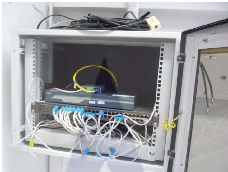
รูปที่ 3.1 ติดตั้ง Router
