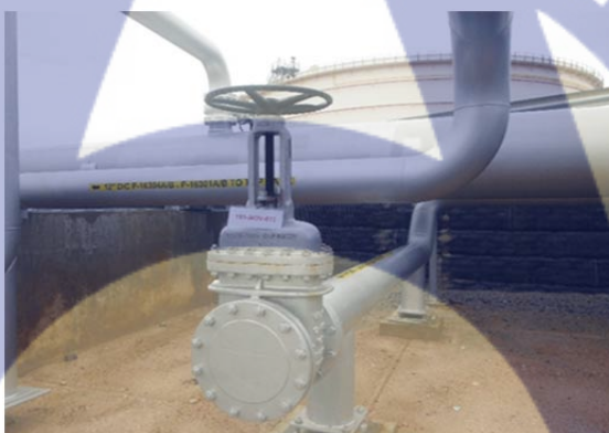
รูปที่ 2.5 Manual Gate Valve
