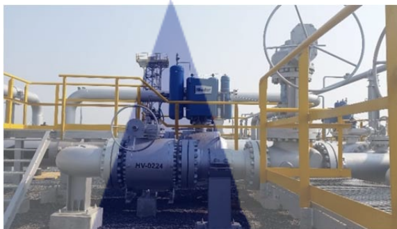
รูปที่ 2.4 หัวขับเคลื่อนชนิดใช้แก๊ส
